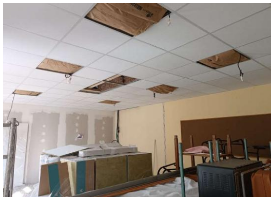
Salle en cours de travaux
